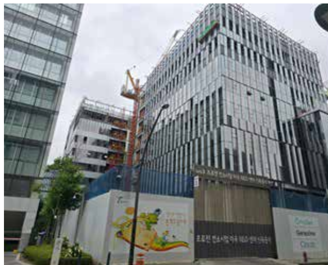
韓国ソウル市マゴクに建設中の Cellid 社の新本社
